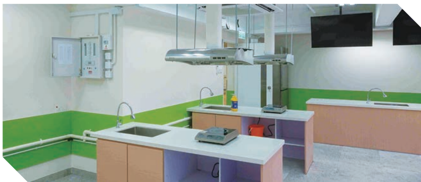
仁愛堂專業培訓中心(九龍西)9樓全層擴展工程。
